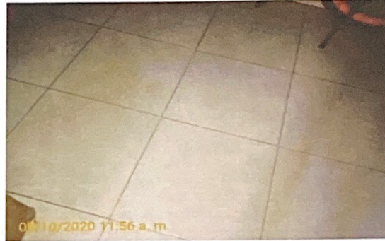
FOTO 8. Enchape de piso de sala en buenas condiciones.
