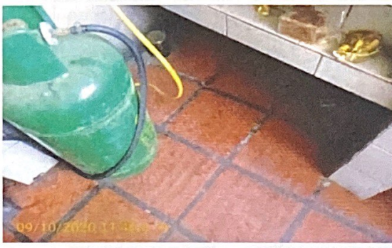
FOTO 6. Piso enchapado en cerámica en buen estado.
