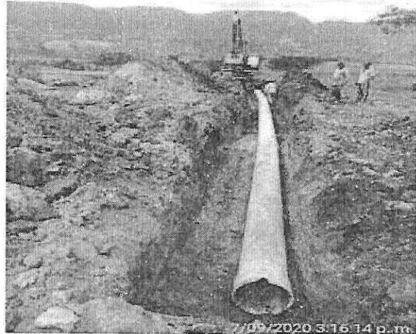
Fotografías: Instalación tubería en cruce de agua, vía de acceso.
