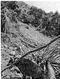
FOTOS PILCUAN DERRUMBE 2021-01-17 at 12.00.55 PM.jpeg 228K
