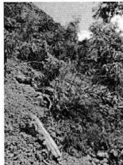
FOTOS PILCUAN DERRUMBE 2021-01-17 at 12.01.54 PM.jpeg 239K
