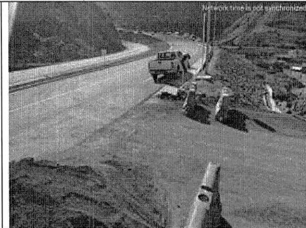
Fecha: 14/01/2021 Descripción: Vía de acceso Vereda El Porvenir-Doble calzada, sector nuevo CCO, Terraplén TR307
