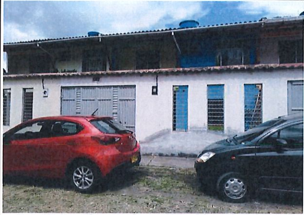
Fachada frontal de la vivienda
