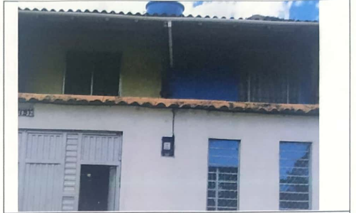
Fachada principal de la vivienda, propiedad de la señora Genith Casanova
