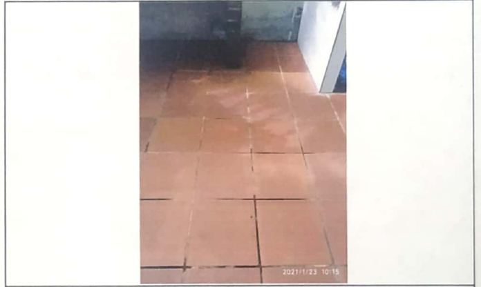
Se observa fisuras en tabletas, la cual es una nueva afectación, por lo cual el propietario pide ser compensado
