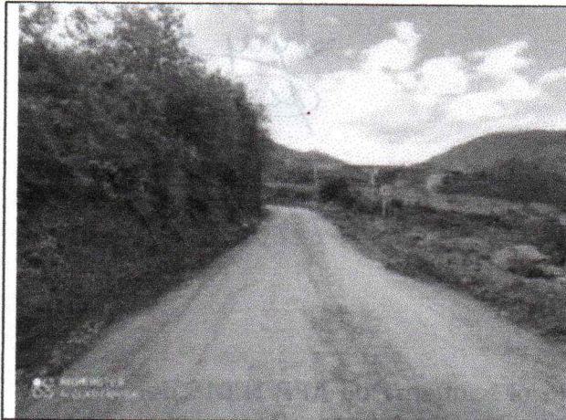
Fecha: 13/01/2021 Descripción: Estado actual vía de acceso, sector Pan de Azúcar – capilla El Porvenir
