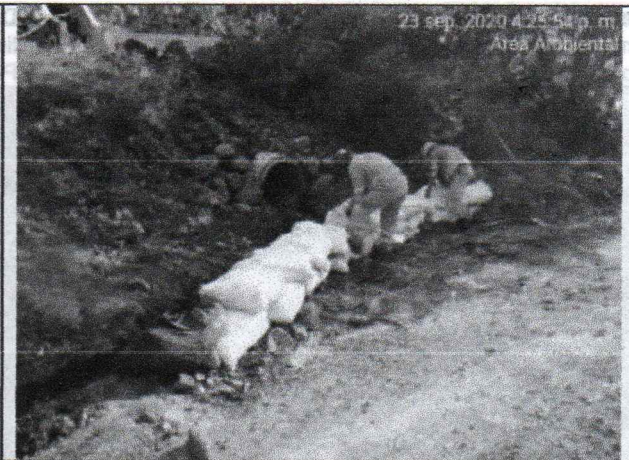
Fecha: 23/09/2020 Descripción: implementación medidas de manejo, limpieza de cunetas y protección de vía, sector El Porvenir.
