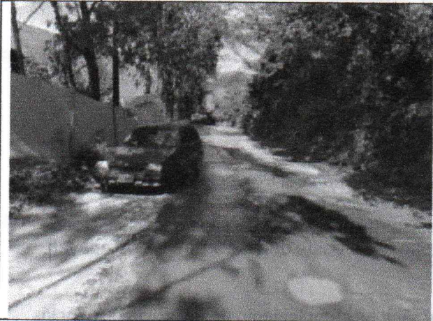
Fecha: 13/01/2021 Descripción: Estado actual vía de acceso, sector Pan de Azúcar – entrada campamento Mikel-capilla El Porvenir.
