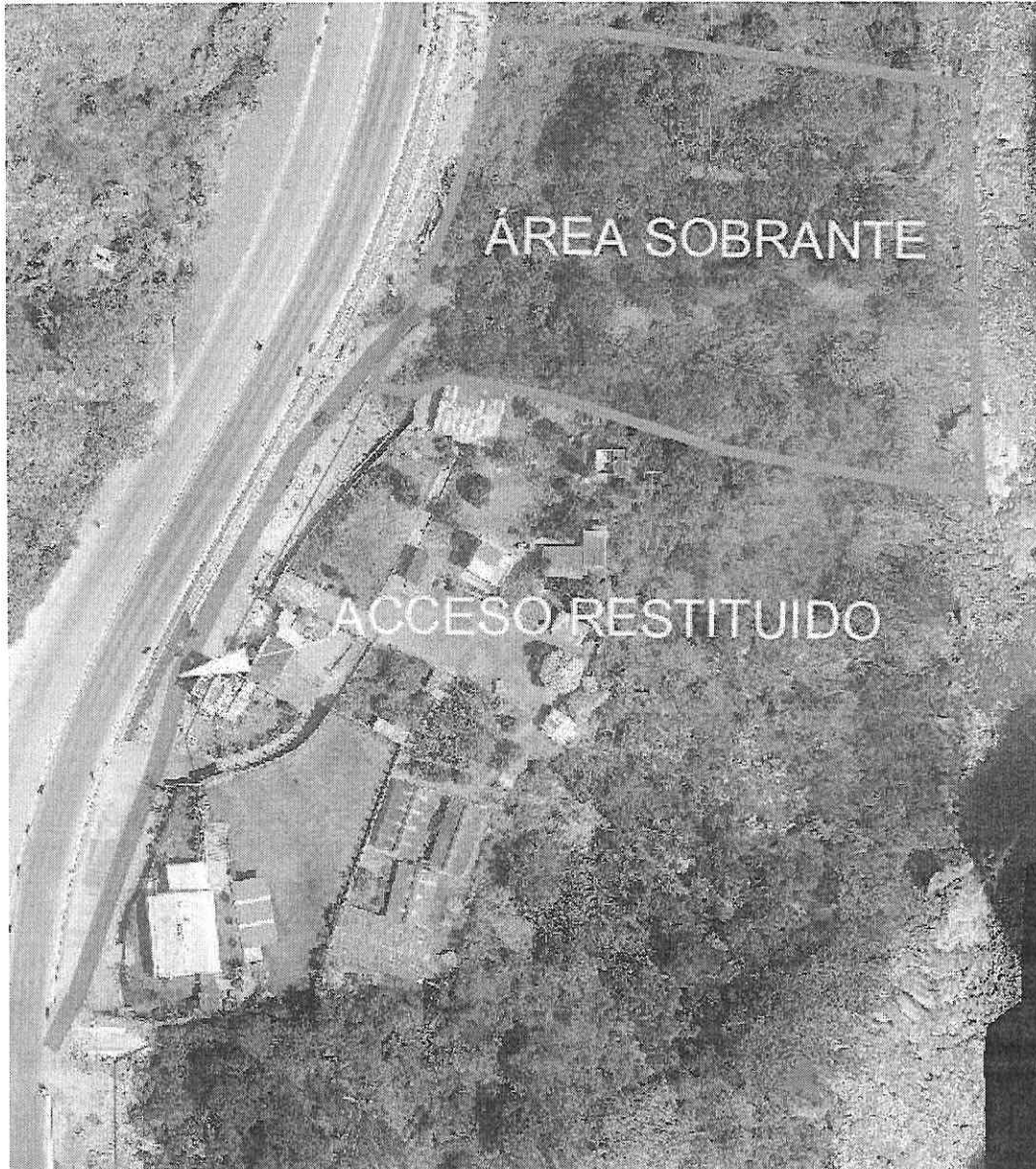
Fotografía No 7. Acceso de tipo peatonal al Área Sobrante antes de las intervenciones del proyecto.
