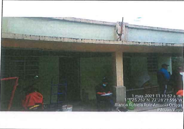
Identificación de fachada frontal de la vivienda
