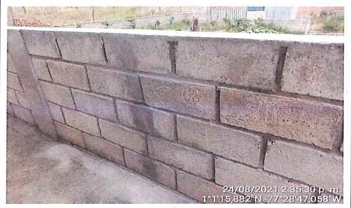
FOTO 2. Reparación del muro de cerramiento.
