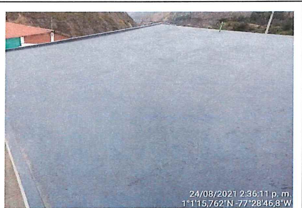
FOTO 3. Reparación de fisuras en losa.
