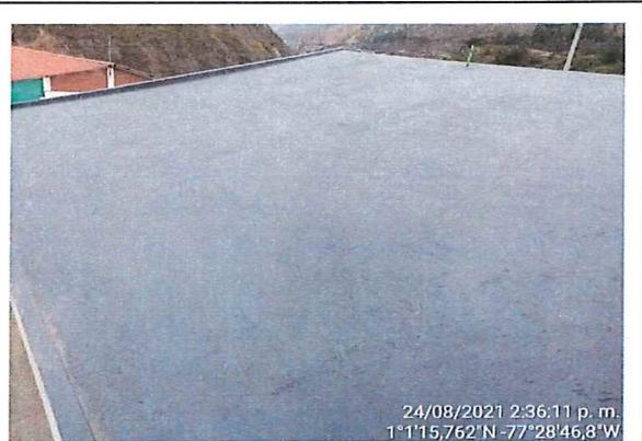
FOTO 3. Reparación de fisuras en losa.
