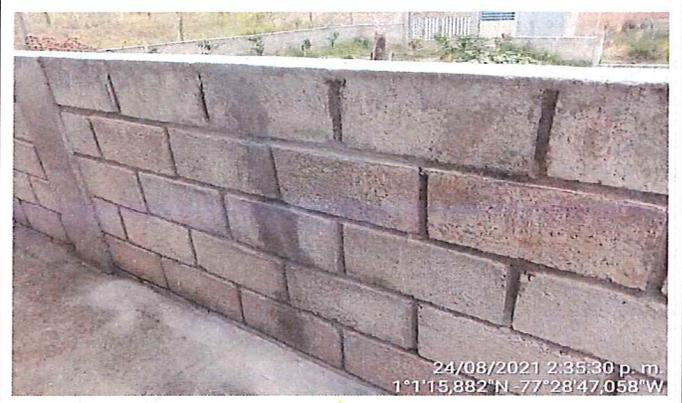
FOTO 2. Reparación del muro de cerramiento.
