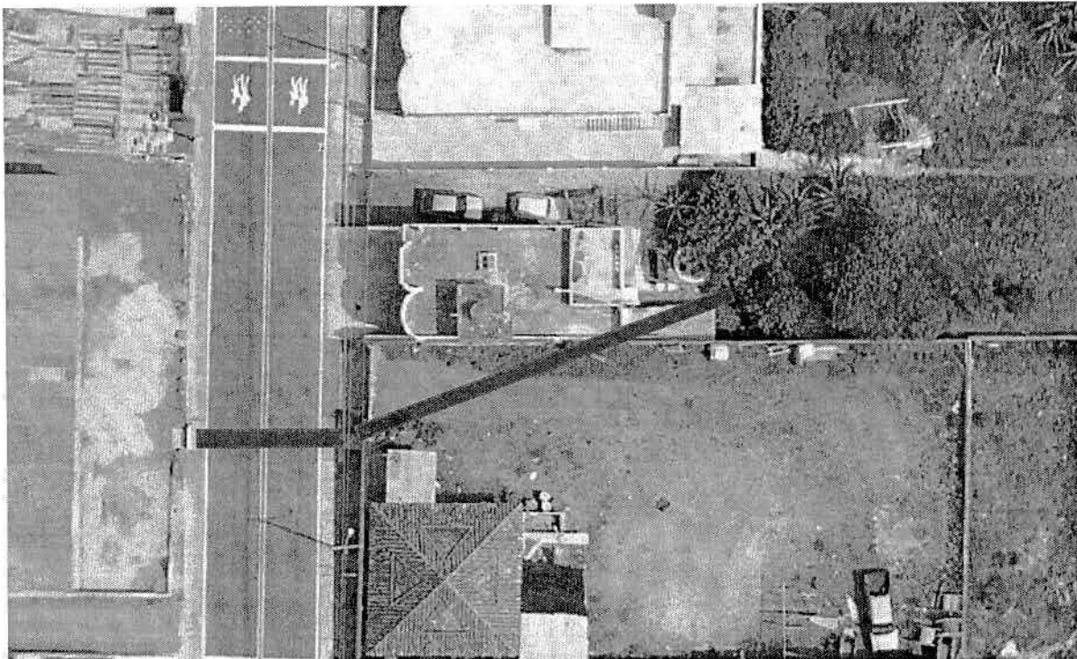
Imagen 4: Trayectoria de tubería canalizada para descole de alcantarilla año 2014.
