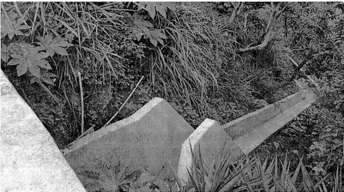
Estructura de descole de la alcantarilla sobre la vía de Funes
