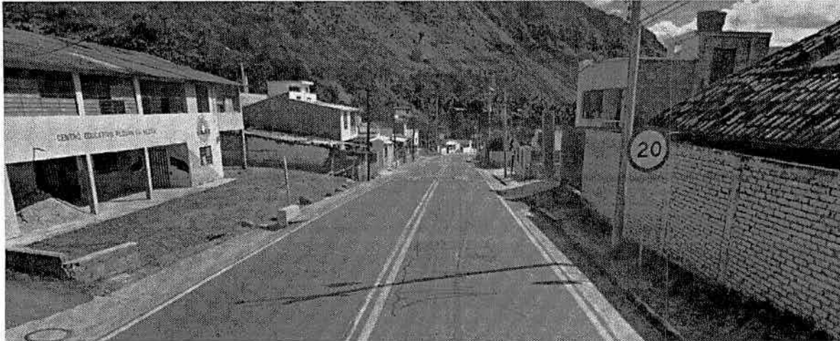
Imagen 1: Caja de alcantarilla tapada margen derecho año 2014.
