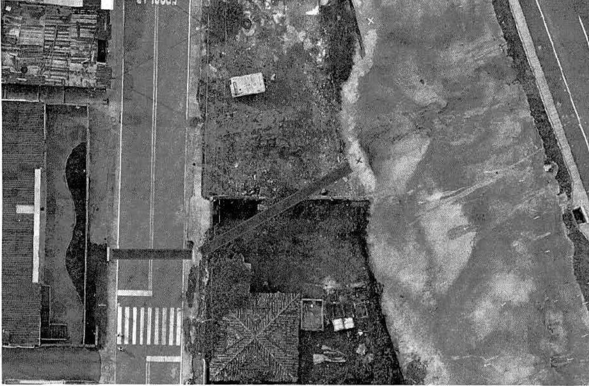
Imagen 5: Trayectoria de tubería canalizada para descole de alcantarilla año 2021.
